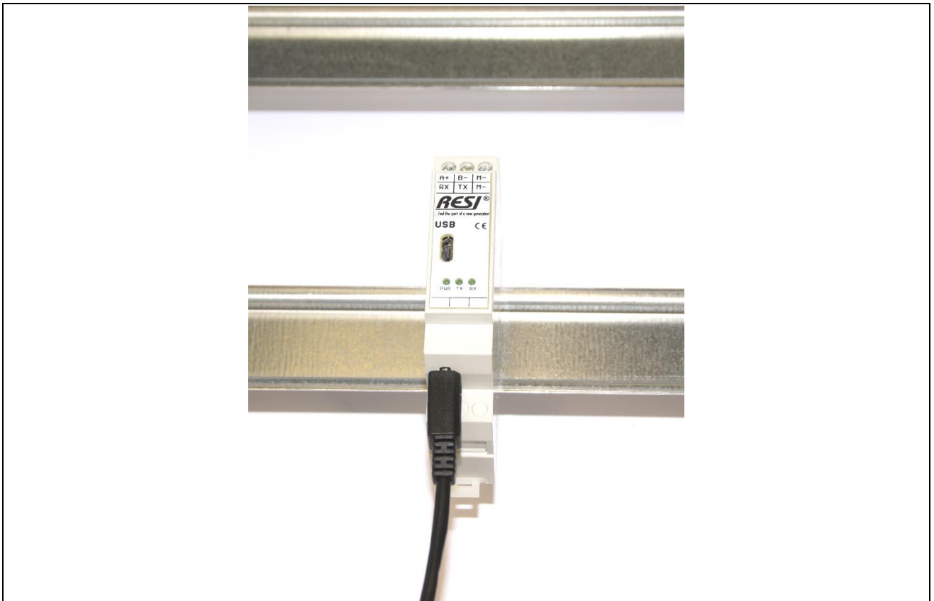
Abbildung: Eingang des USB Kabels unterhalb des 45mm Maskenausschnitt nach innen, um interne USB Geräte innerhalb des Schaltschranks anzuschließen
